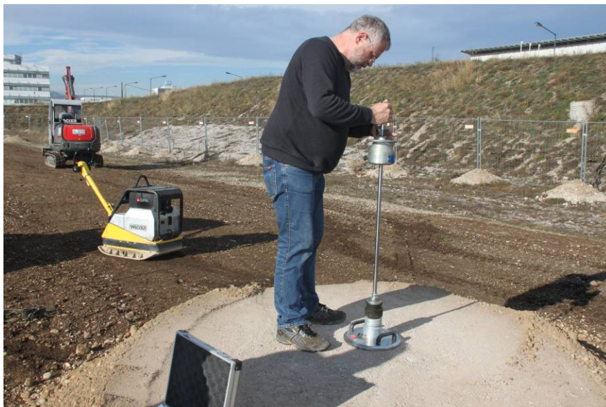
1. Überprüfung der Verdichtung mittels Fallgewichtgerät
