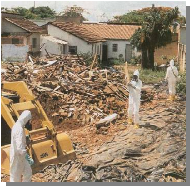
Abb. 2, 3, 4: Dekontamination durch Abtragen der Gebäude in Goiania.
