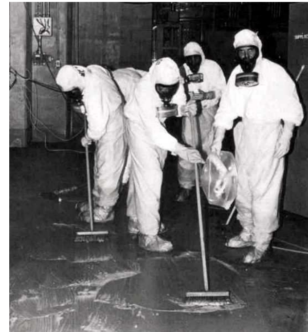
Dekontamination im Reaktorhilfsanlagengebäude, Oktober 1979
